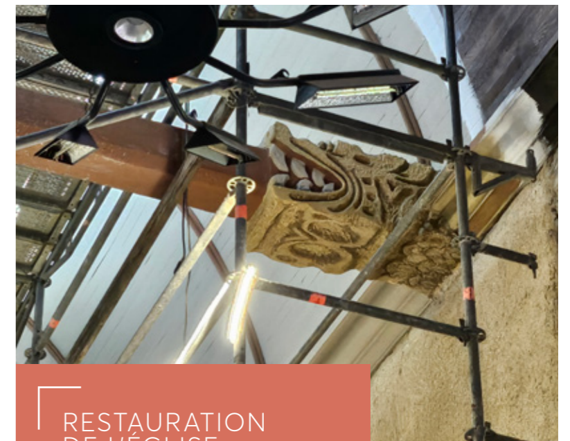
Mise en teinte de l'engoulant
