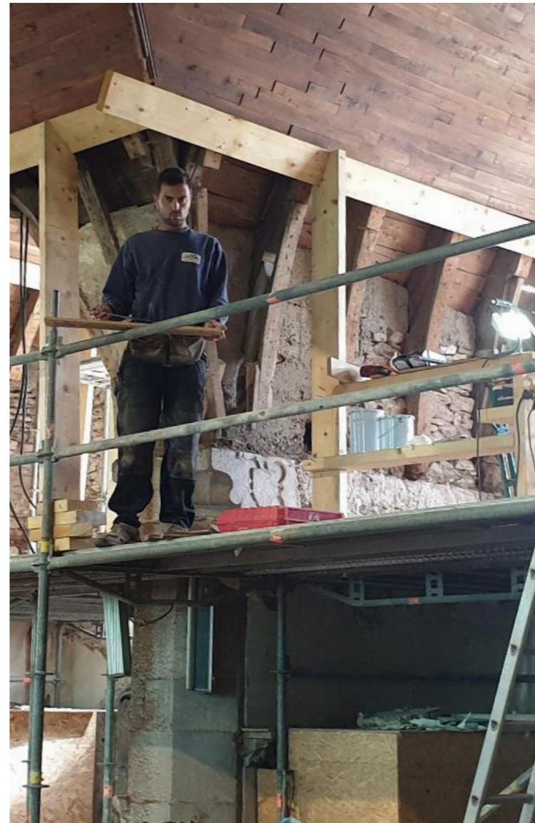
< Changement des linteaux par le menuisier
